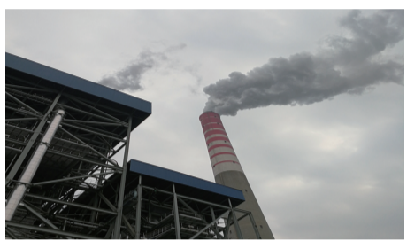
图4 电厂湿法脱硫后排出的白烟气
